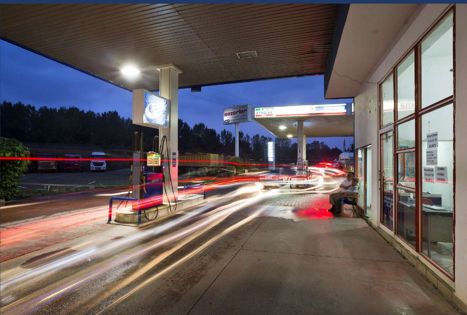
ARİFİYE'DE ELGAZ BENZİN İSTASYONUNDA ÖLÇÜLEN 5 METRELİK YANAL ATIM
